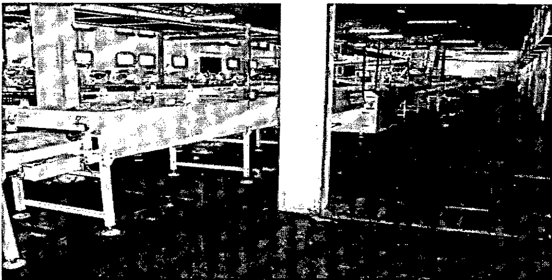
ITEM 103 - TÚNEL RESFRIAMENTO LIMAC
