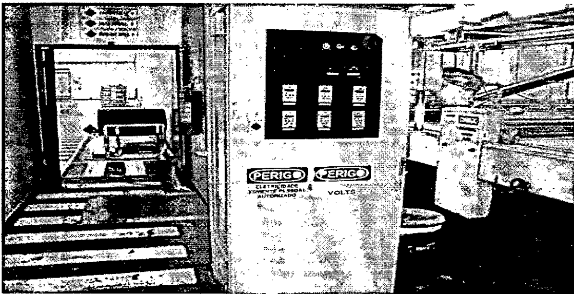
ITEM 81 - QUADRO COMANDO LAMINAÇÃO
