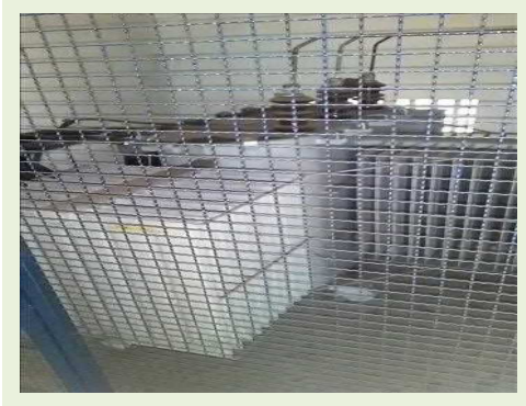
TRANSFORMADOR TRIFÁSICO DE TENSÃO A ÓLEO POT. 500 KVA TENSÃO DE ENTRADA 13800V TENSÃO DE SAÍDA 330 V - CABINE SECUNDÁRIA 330V | Item: 55 |
