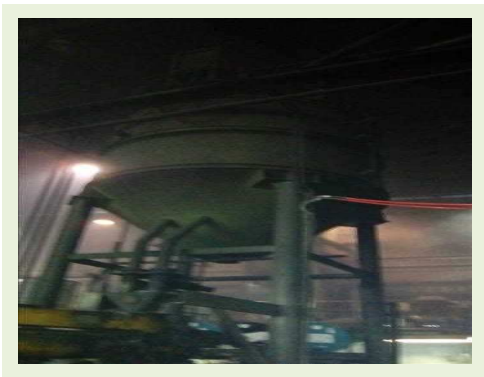
SISTEMA DE REGENERAÇÃO DE AREIA E TRANSPORTE MARCA IMF CAP. 12 T/H, | Item: 111 | SISTEMA DE REGENERAÇÃO DE AREIA E TRANSPORTE MARCA IMF CAP. 12 T/H, | Item: 111 |
