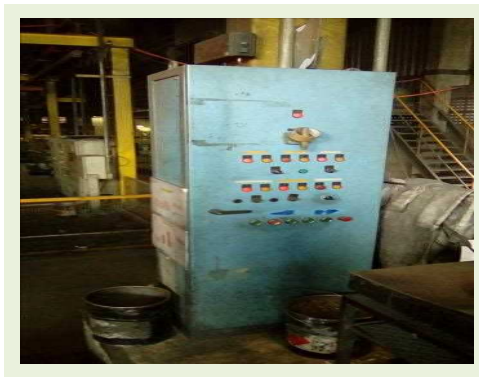
PAINEL ELÉTRICO PARA O CARRO E TORRE DE REFRIGERAÇÃO 380 V DIM. 650X400X2.000 M | Item: 65 |
