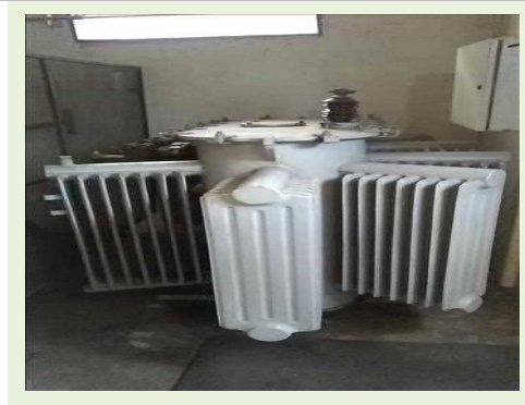
TRANSFORMADOR TRIFÁSICO DE TENSÃO A ÓLEO POT. 500 KVA TENSÃO DE ENTRADA 13800V TENSÃO DE SAÍDA 220/127 V - CABINE PRIMÁRIA (DESATIVO) | Item: 134 |
