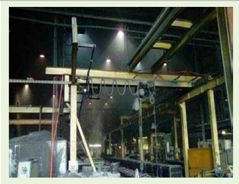
PONTE ROLANTE MONOVIGA MARCA SAMM COM TALHA ELÉTRICA DE CORRENTE MARCA SAM CAP. 3 TON; VÃO 5,5 M | Item: 31 |
