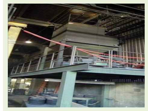
SILLO DE AÇO CARBONO BIPARTIDO PARA DESCARGA DE AREIA NOVA CAP. 5 T (DESATIVADO) | Item: 56 |
