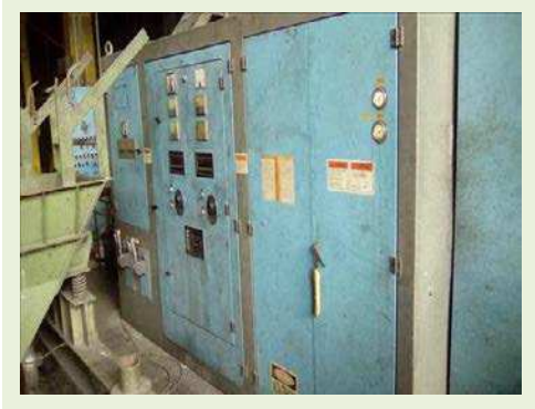
SISTEMA PARA FUNDIÇÃO DE METAIS MARCA INDUCTOTHERM MOD. VIP DUALTRAK 600 KW COMPOSTO POR: 2 FORNOS ELÉTRICOS DE INDUÇÃO MARCA INDUCTOTHERM MOD. VIP 600 KW CAP. 1.000 KG CADA, 1 CUBÍCULO ELÉTRICO 13.800 V, 1 PAINEL ELÉTRICO 625 V PARA FORNOS MARCA INCOTHERM | Item: 26 |
