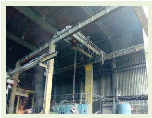
PONTE ROLANTE DUO VIGA MARCA SAMM HOT JUBER COM TALHA ELÉTRICA DE CORRENTE CAP. 3 TON 380V; VÃO 5 M X CAMINHO DE ROLAMENTO 16 M, ELEVAÇÃO APROXIMADA 5 M | Item: 95 |
