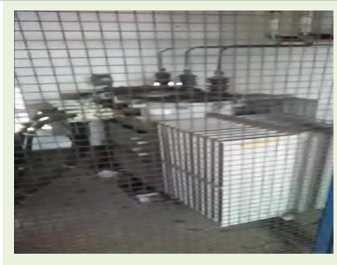
TRANSFORMADOR TRIFÁSICO DE TENSÃO A ÓLEO POT. 500 KVA TENSÃO DE ENTRADA 13800V TENSÃO DE SAÍDA 220 V - CABINE SECUNDÁRIA 220V | Item: 20 |
