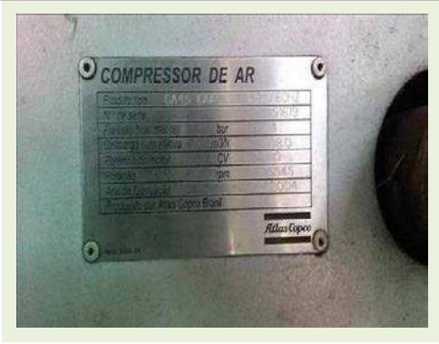
COMPRESSOR DE AR MARCA ATLAS COPCO MOD. GA 45 ,100P, SÉRIE 451619, COM MOTOR 60 CV | Item: 33 |
