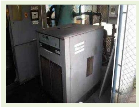
SECADOR DE AR MARCA ATLAS COPCO MOD. FD380, SÉRIE FD850719, PESO 150 KG | Item: 41 |
