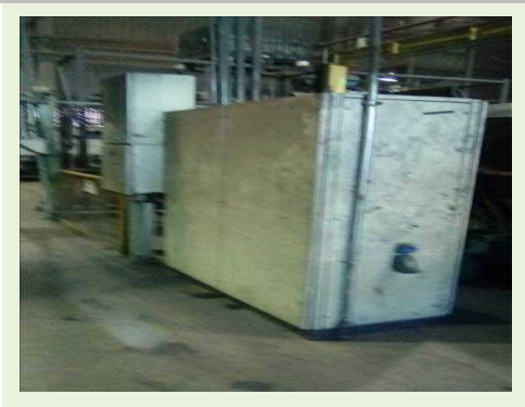
PAINEL ELÉTRICO 380 V PARA MESA BASCULANTE, CARRO 2 E MESA VIBRATÓRIA 380V DIM. 2.100X650X1.900 MM | Item: 112 |
