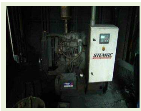
GRUPO GERADOR MARCA STEMAC MOD. ST2130 POT. 33/30, 380 V NS. 912574, COM GERADOR MOD. D4BB-G2 E MOTOR MARCA HYUNDAI, SEM CARENAGEM | Item: 29 |
