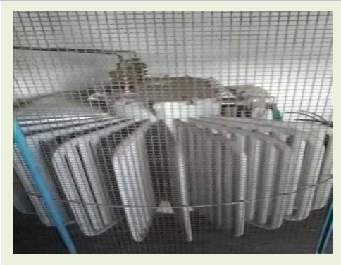
TRANSFORMADOR TRIFÁSICO DE TENSÃO A ÓLEO MARCA UNIÃO POT. 500 KVA TENSÃO DE ENTRADA 13800V TENSÃO DE SAÍDA 220/127 V - SERIE 314.352 | Item: 118 |
