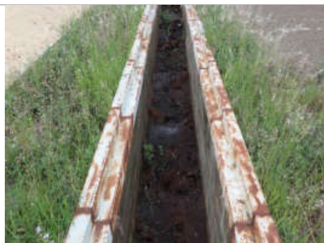
Passagem de cabos elétricos
