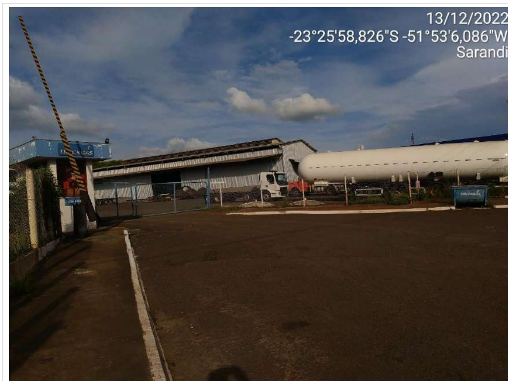
F01- Imagem geral do imóvel visto pelo logradouro – Avenida Ademar Bornia.
