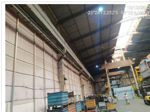
F15 - Imagem do barracão denominado B06, imagem externa.
