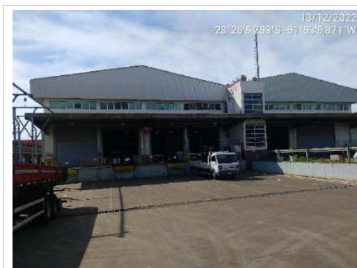
F17 - Imagem do barracão denominado almoxarifado/escritório, imagem externa.
