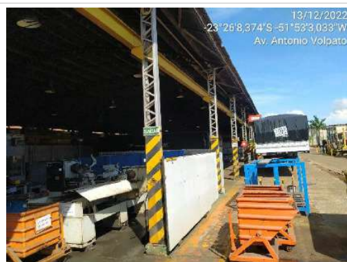
F07- Imagem do barracão denominado B03, imagem externa.
