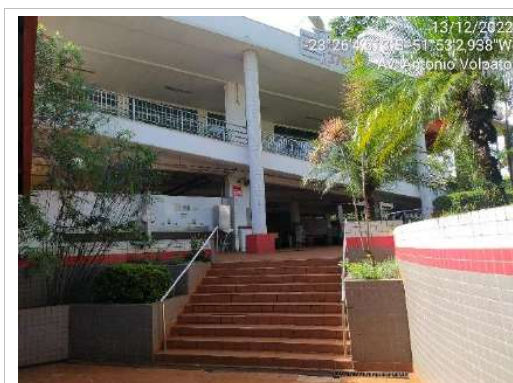
F21 - Imagem do barracão denominado Vestiário/Restaurante, imagem externa.
