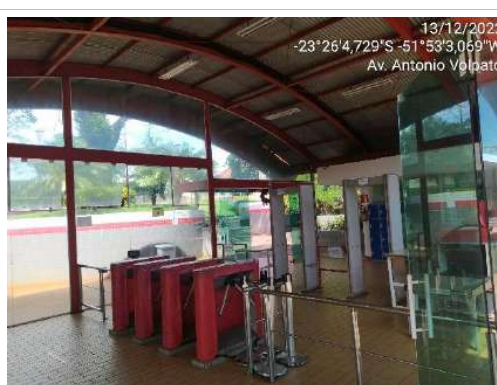
F26- Imagem do barracão denominado Portaria, imagem interna.
