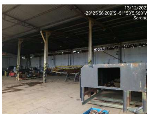
F09- Imagem do interior do barracão 02- que fica ao fundo do terreno.
