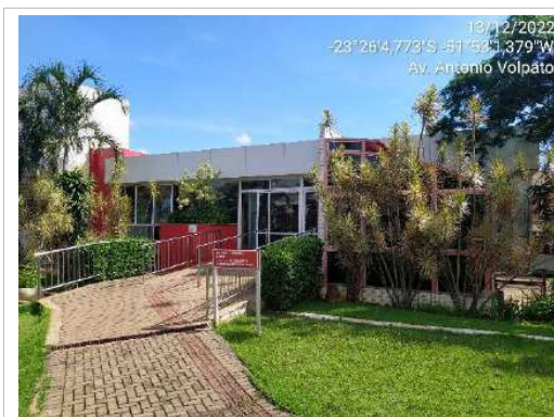
F27 - Imagem do barracão denominado Ambulatório/Treinamento, imagem externa.
