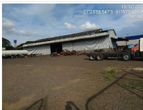
F03 – Imagem do barracão 01 (lado direito), vista pelo interior do terreno.
