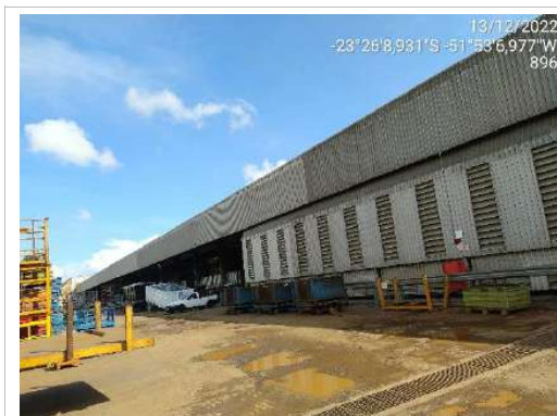
F13 - Imagem do barracão denominado B06, imagem externa.
