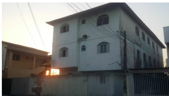
Vista da fachada principal
