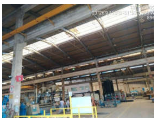
F14- Imagem do barracão denominado B06, imagem interna.
