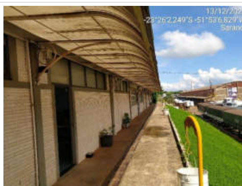
F02- Imagem do barracão denominado como B01, imagem externa.
