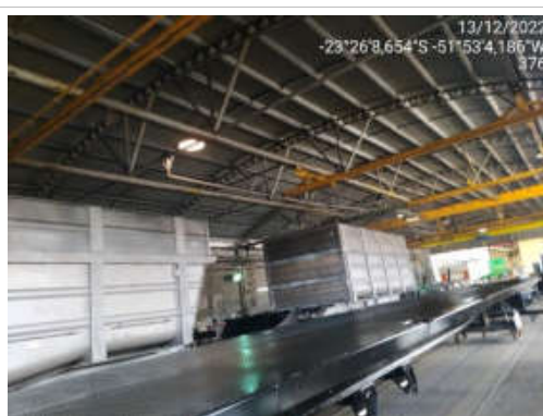
F10- Imagem do barracão denominado B04, imagem interna.
