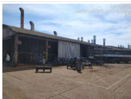
F09- Imagem do barracão denominado B04, imagem externa.
