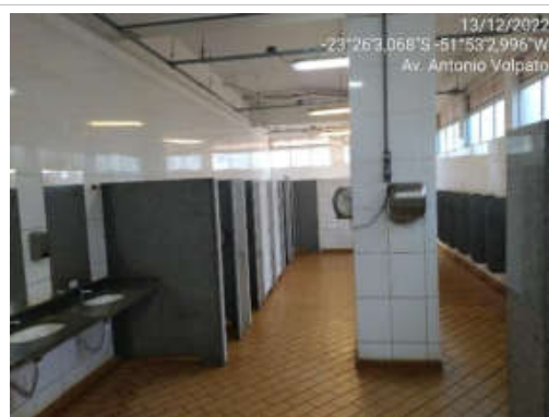
F23 - Imagem do barracão denominado Vestiário/Restaurante, imagem interna do sanitário do vestiário.
