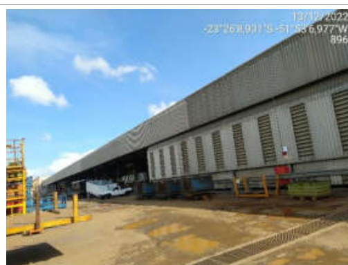
F13 - Imagem do barracão denominado B06, imagem externa.
