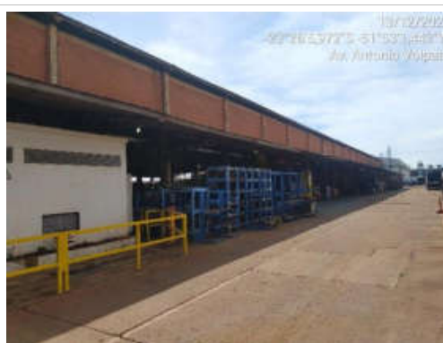
F04 – Imagem do barracão denominado B02, imagem externa.
