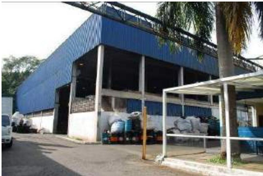
Trata-se de uma edificação térrea com, aproximadamente, 2.440,54 m<sup>2</sup> de área construída, do tipo Galpão de Padrão Médio (-), que denota idade de 6 (seis) anos e encontra-se em estado de conservação entre regular e necessitando de reparos simples “d”.
