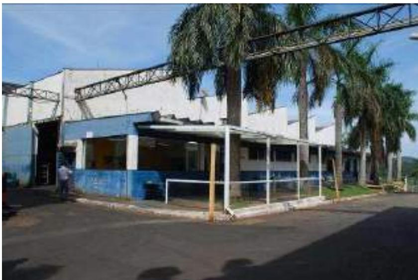
Trata-se de uma edificação com mezanino, do tipo Galpão de Padrão Médio (+/-) com, aproximadamente, 1.507,41 m<sup>2</sup> de área construída, que denota idade de 40 (quarenta) anos e encontra-se em estado de conservação necessitando de reparos simples “e”.
