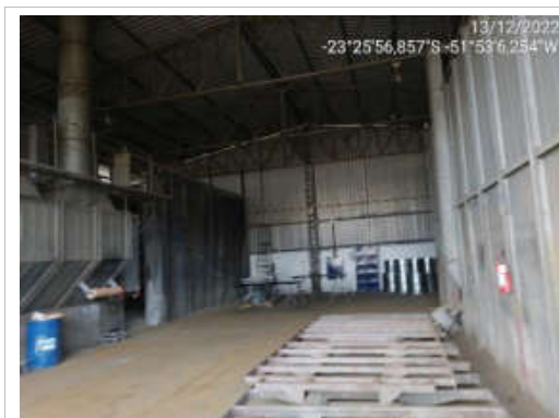
F10 - Imagem do interior do barracão 03- ao lado esquerdo entrando no terreno.
