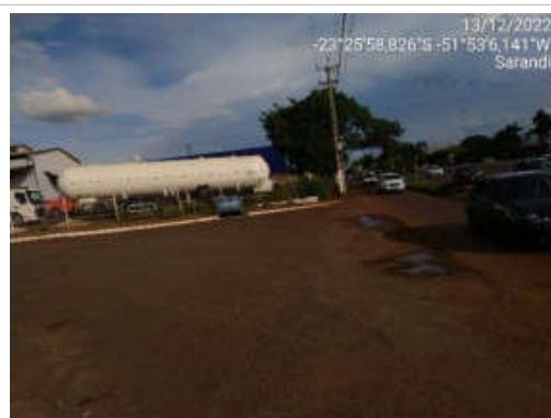
F02- Logradouro Avenida Ademar Bornia – imóvel lado esquerdo.
