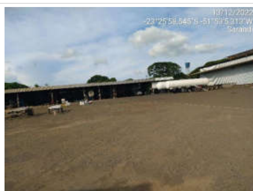
F04- Imagem do barracão 02 (ao fundo), vista pelo interior do terreno.
