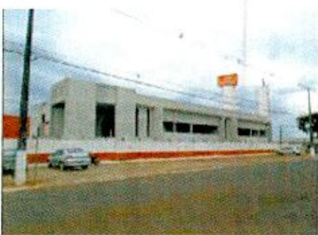
Frente para Av. Guaratingá
