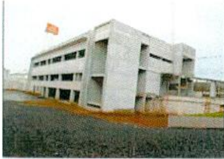
Prédio da administração-em construção
