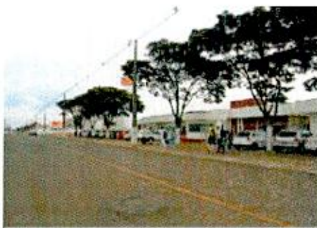
Aspecto da frente do imóvel
