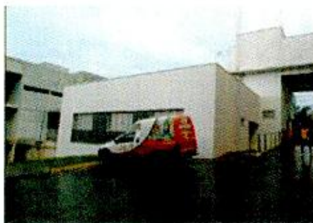
Prédio da portaria, RH e Expedição
