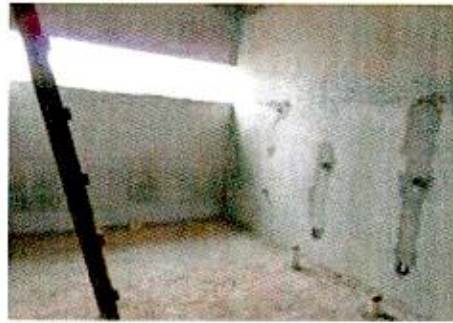
Sanitário do piso superior
