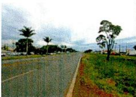
Aspecto da rodovia e marginais
