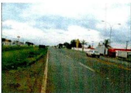
Aspecto da rodovia e marginais
