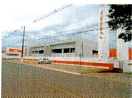
Frente para Av. Guaratingá
