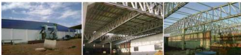
Sadia | Abatedouro de Aves | Brasília DF | 8.430,32m 2
