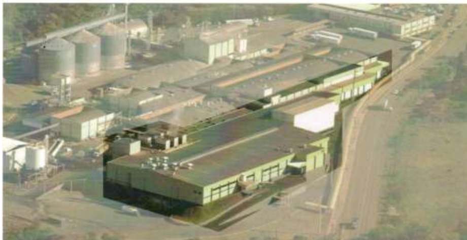
Sadia | Ampliação Abatedouro de Perus | Francisco Beltrão PR | 6.294,28m 2
