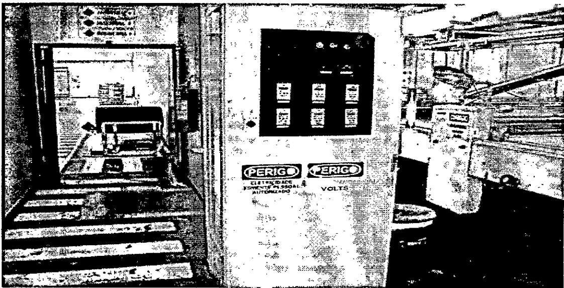
ITEM 81 - QUADRO COMANDO LAMINAÇÃO
