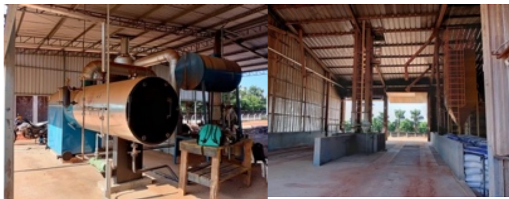
Figura nº 02 - Melhorias em Instalações e Equipamentos.
