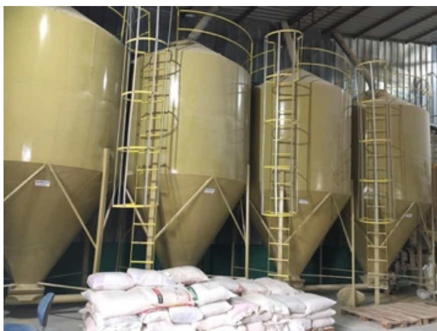
Figura 21 – Silos de Armazenamento de Matérias Primas. FONTE: Acervo da Empresa
