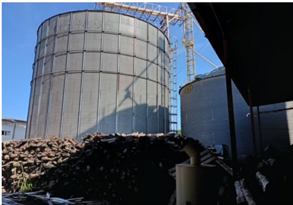
Figura nº 19 – Silos para Armazenagem de Grãos de Soja e Milho
